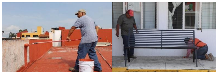
Instalaciones internas y techos.
