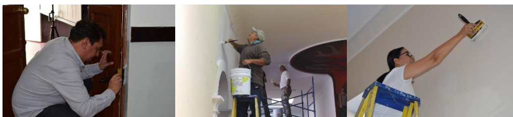
Remozamiento de pintura en interiores.
